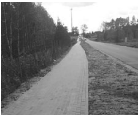
Budowa chodnika przy drodze powiatowej w Boluminku.
