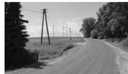
Modernizacja drogi gminnej nr 050508C w Boluminku.
