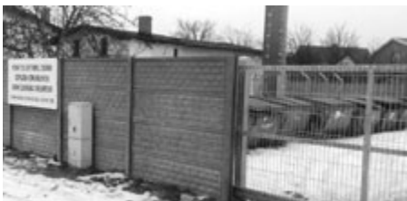
Utworzony został stacjonarny PUNKT SELEKTYWNEJ ZBIÓRKI ODPADÓW KOMUNALNYCH.
